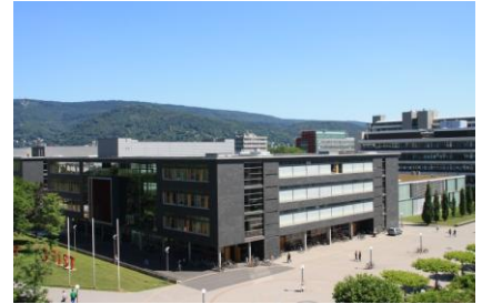
Auf dem Dach des Kirchoff-Instituts für Physik entsteht im Neuenheimer Feld die erste „Bürger-Solaranlage“ in Heidelberg
