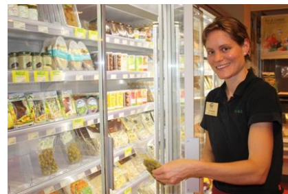
Türen vor den Kühltheken senken den Energieverbrauch im Kühlbereich um 60 Prozent.
